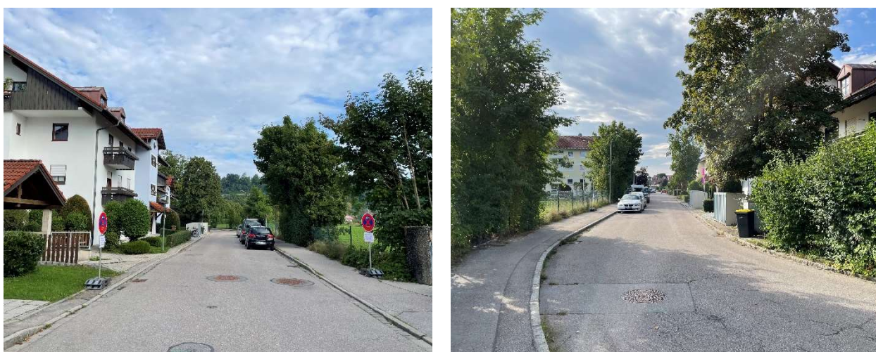
Abbildung 3: Nördlicher Bereich Gipsenweg in Blickrichtung Nord (links) und Süd (rechts) [PSLV, August 2025]
